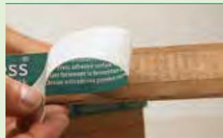
Silikonband vom Selbstklebeverschluss lösen
